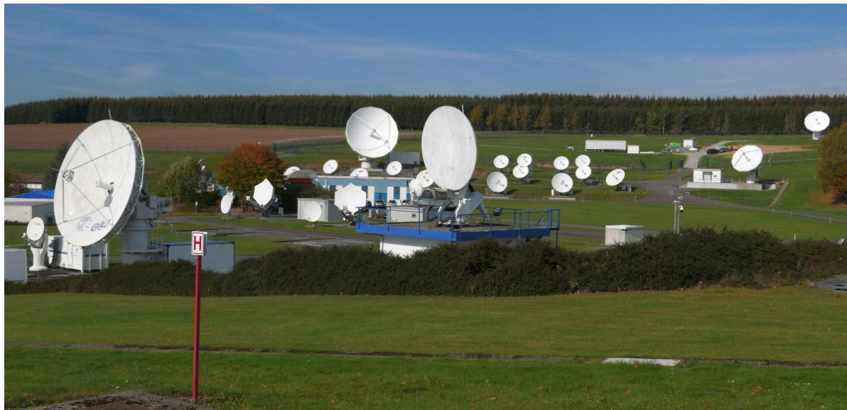
Obr. 4 - Radiokomunikační stanice Redu (foto: Jan Veselý)
